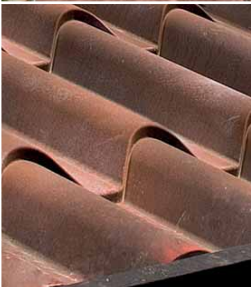
Dettaglio della copertura
